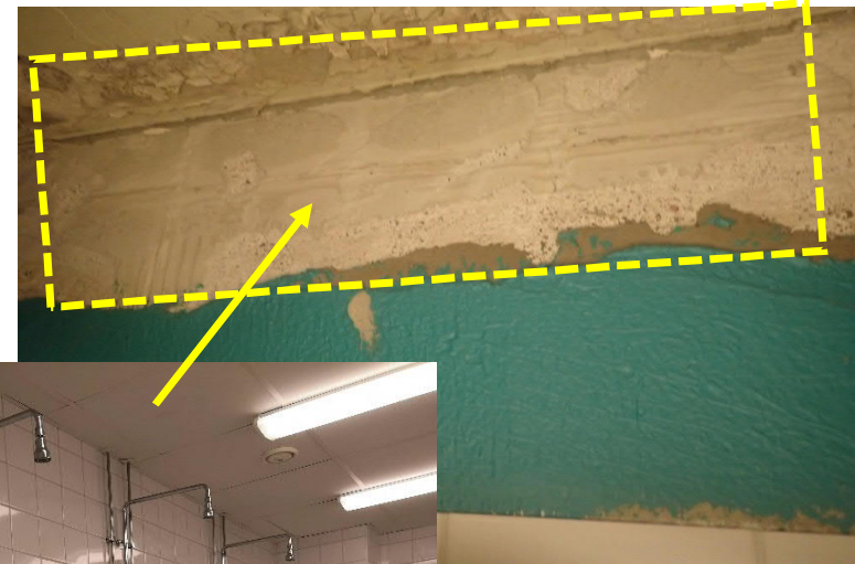
Vanhaa kiinnityslaastia
