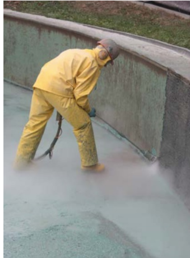
Vanhan rakenteen poisto
