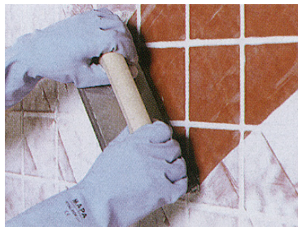
Ylimääräisen epoksisauman poisto laatan pinnalta
